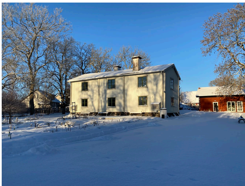
Figur 8. Huvudbyggnadens södra fasad. Foto; Helene Brunnström, Österåkers kommun.
